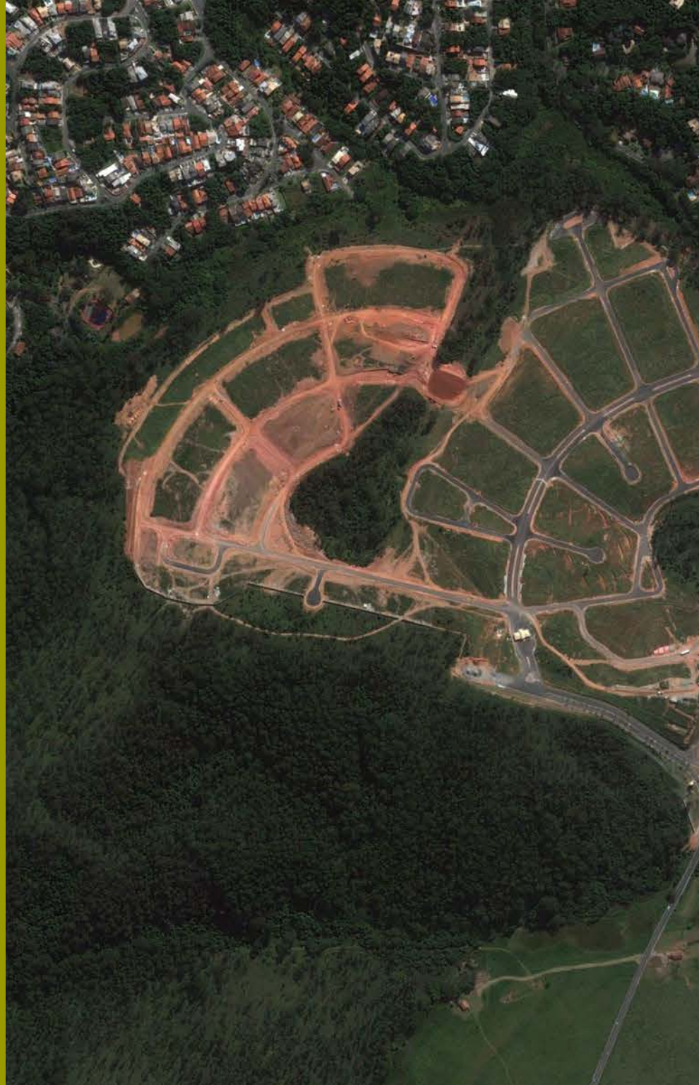
Fazenda Santa Maria Jandira, SP obras em andamento
